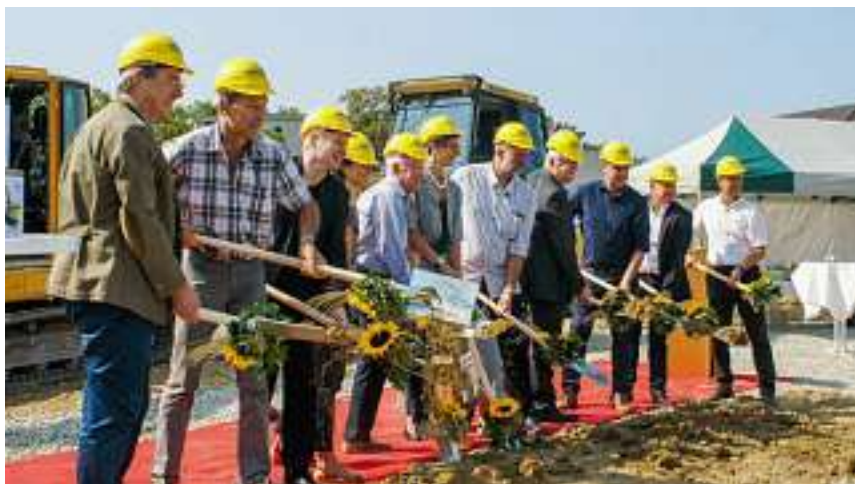
Der Spatenstich der «Altstadt» ging erfolgreich über die Bühne
