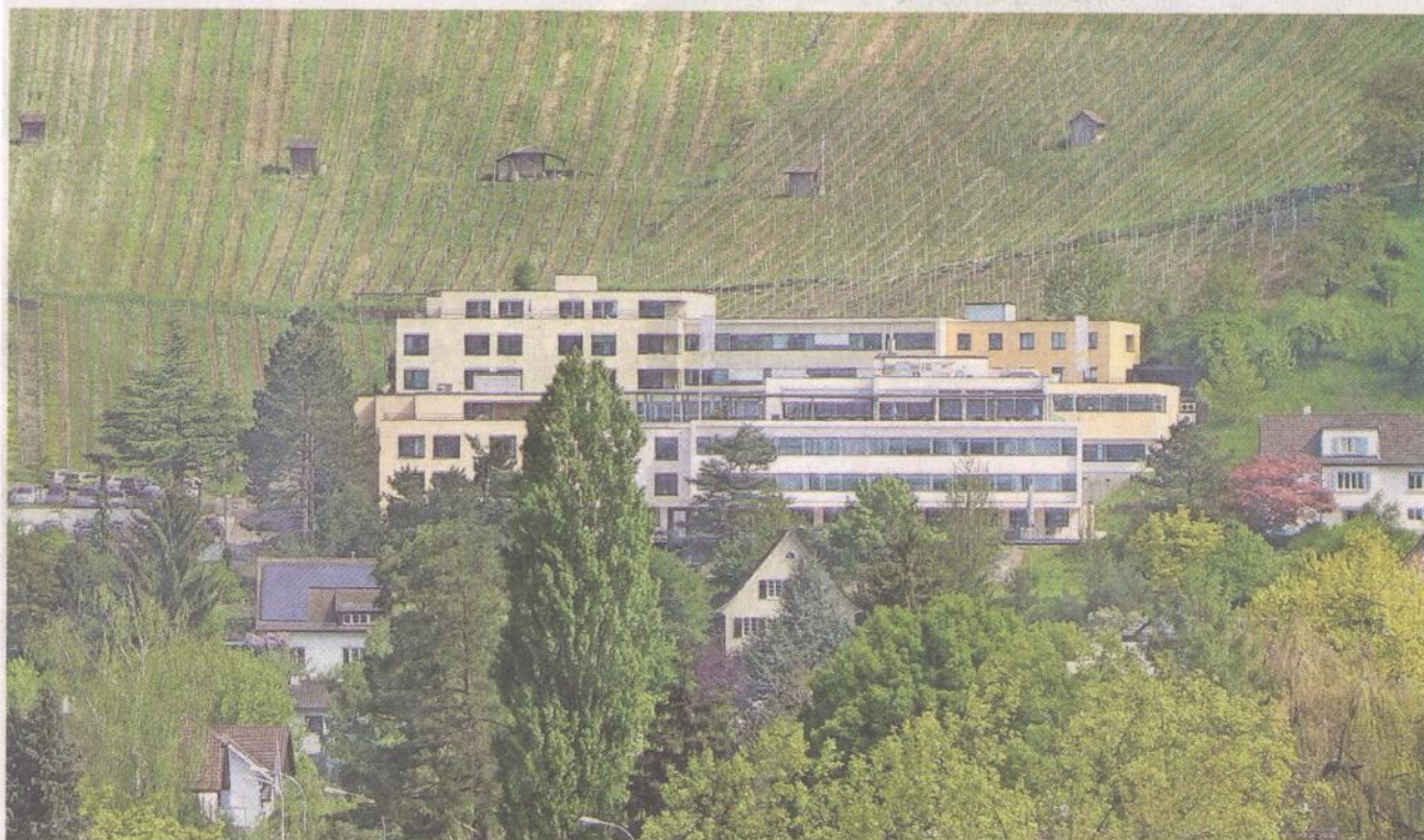
Die Tage des Alters- und Pflegeheims St. Bernhard sind nach rund 110 Jahren gezählt. 1905 war das an dieser Stelle stehende Bergtröttli zum Altersasyl umgebaut worden.
